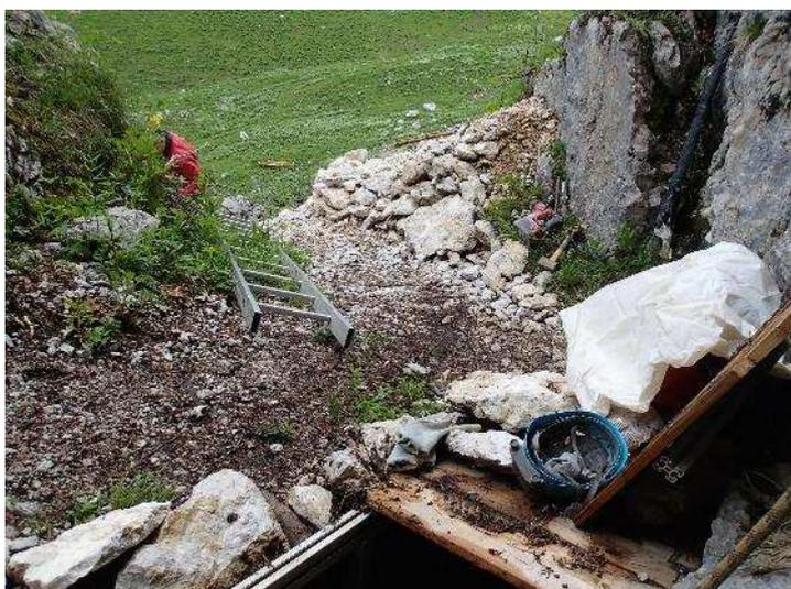
Mise en place de l'échelle dans le ressut d'entrée. On perce , on met les goujons, et on tape.
