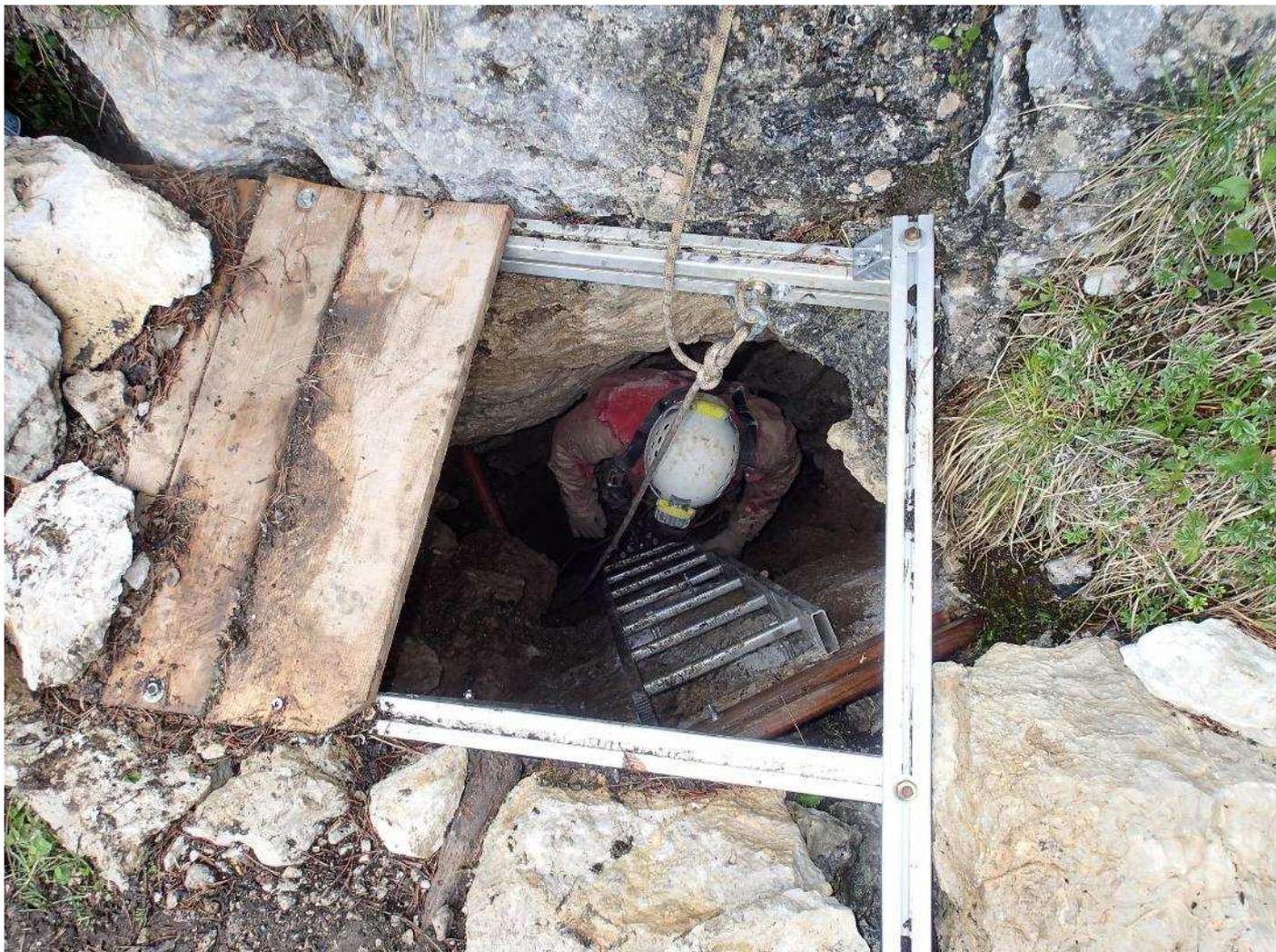
Reste à desoiber au fond. Il y a un etai, des barres d'aluminium, 4 planchettes en bois. Faut descendre du boisage pour la suite de la desob et éventuellement les dessous de la tremie d'entrée, sortir encore des seaux, et agrandir les 2 zones étroites que l'on voit devant.
